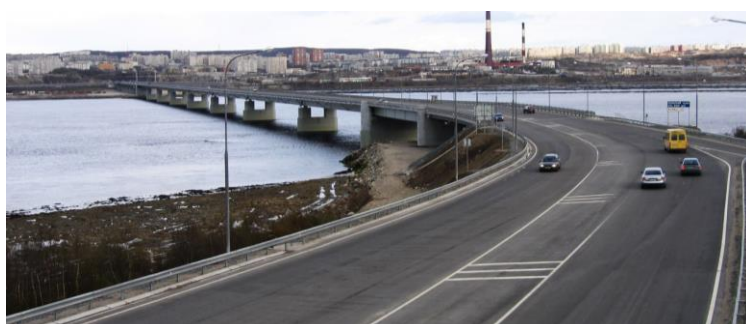
Мост через Кольский залив
