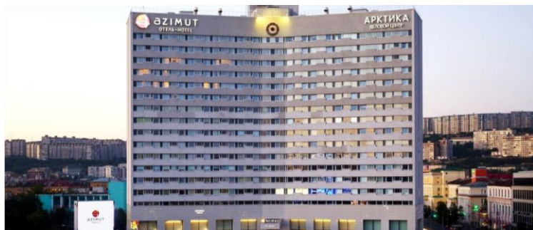
Реконструкция гостиницы «Арктика»
